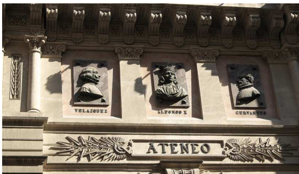
Detalle de la fachada del Ateneo de Madrid.
